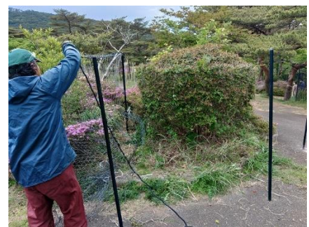
防鹿柵の設置
